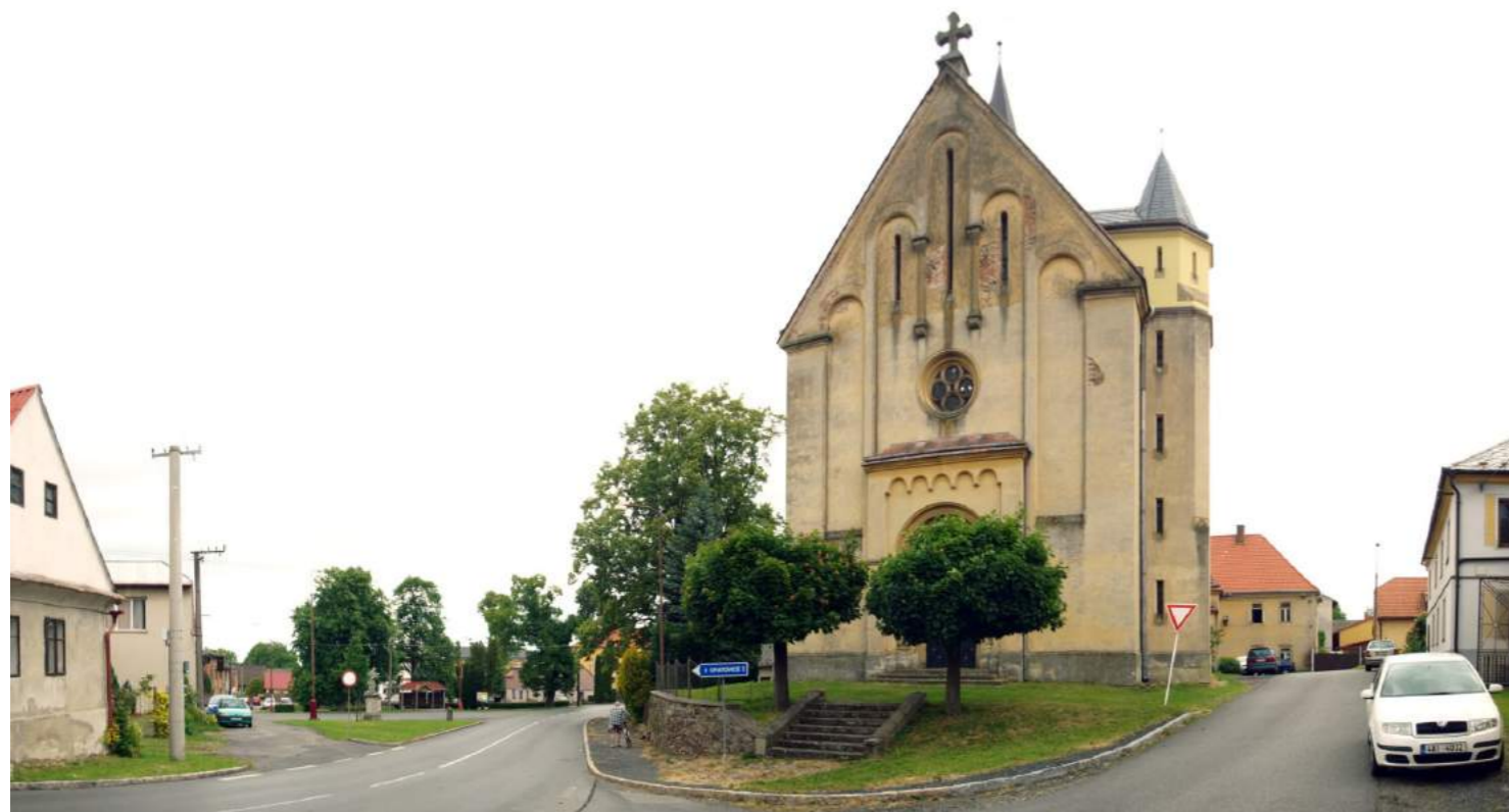
fotografie 1 - pohled na kostel z příjezdové cesty od Zbraslavic
