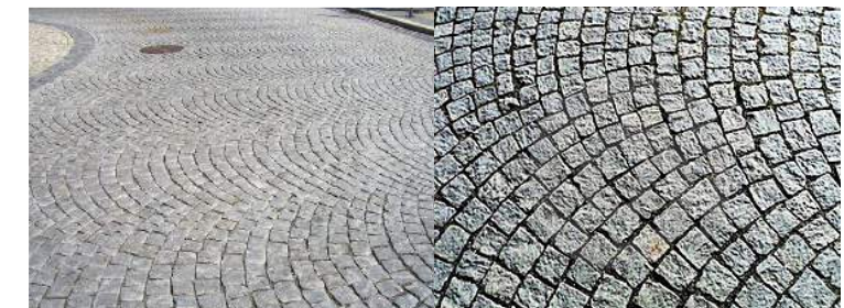
Žulová dlažba - kladení vějířové Dlažební kostky štípané kladené do oblouku Plocha: 978 m 2
